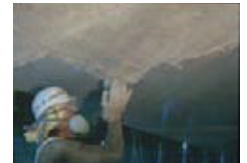
高速道路橋脚のエポキシはがし
